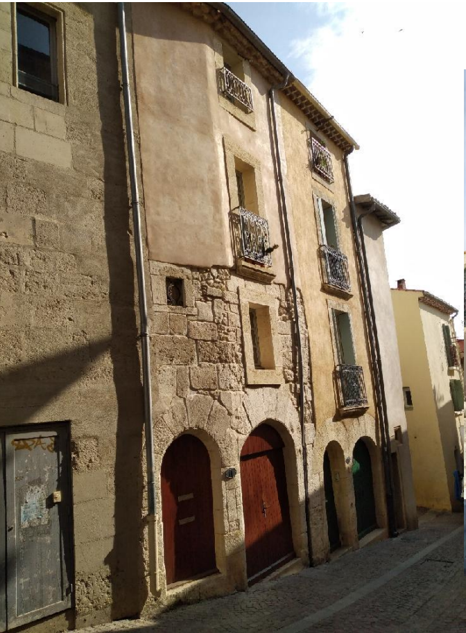
Rue des Anciennes Arènes
